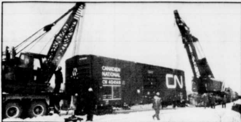
C'est à l'aide de ces deux immenses grues mobiles que les wagons ont été replacés sur les rails.
