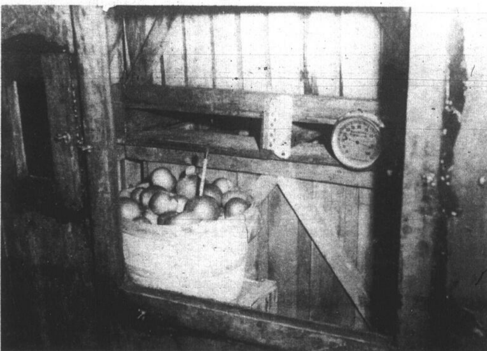
Vue de l'intérieur d'une chambre à atmosphère contrôlée.
