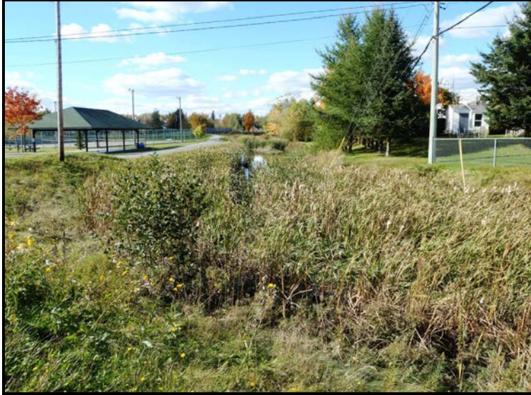
Figure 5.27 : Portion du ruisseau du secteur E faisant office de bassin de rétention (PO-7) longitudinal avec une végétation dense.
