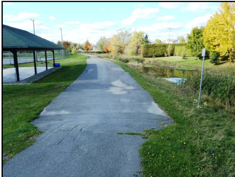
Figure 5.28 : Déversoir par où les eaux passent des bassins de rétention PO-7 (à droite) à PO-1 (à gauche, ce bassin étant un terrain de baseball).
