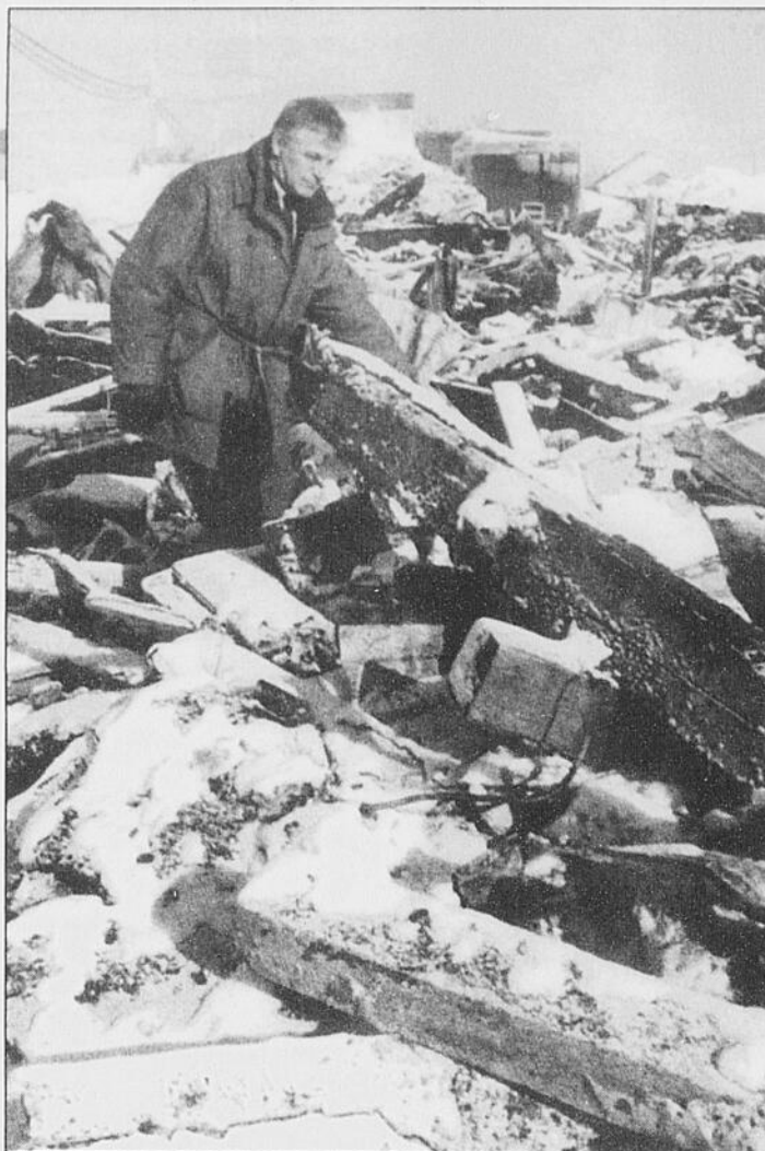
LOURDS DEGATS - Marcel Maltais, que nous apercevons sur cette photo au moment où il constate les dégâts, n'est pas encore en mesure de dire s'il va reconstruire son usine d'Hébertville. (Photo Steeve Tremblay)
