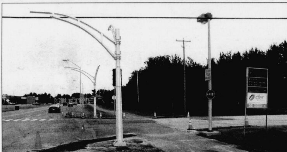
La Ville est à installer de nouveaux feux de circulation sur le boulevard Labbé dans le voisinage des établissements scolaires.
