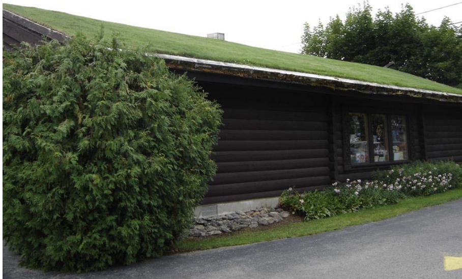
Figure 6.1 Exemple de toit vert extensif.
