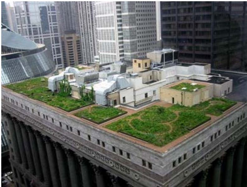
Figure 6.1 Exemple de toit vert extensif.
