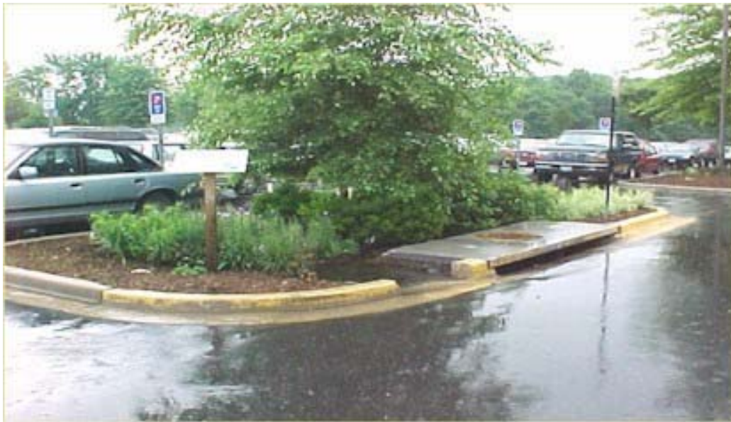
Figure 3.2 Bassin de bio-rétention aménagé dans une aire de stationnement (tiré de DEP, 2006)
