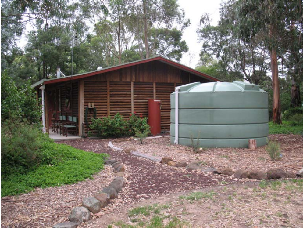
Figure 5.1 Système de collecte des eaux de ruissellement des toits (Southern Grampians Cottages, Dunkeld, Victoria, Australie)
