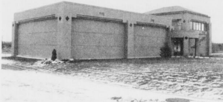
ALLURE - La nouvelle bâtisse a fière allure, en comparaison de l'ancienne, soit la moitié de l'ancienne gare locale.
