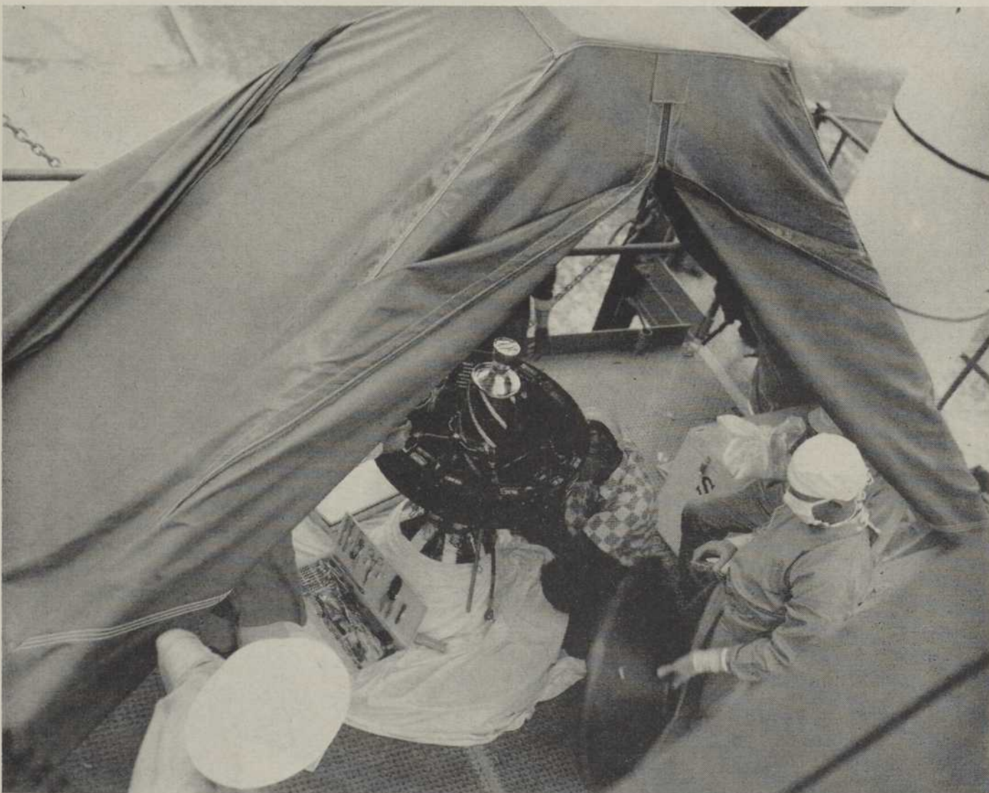
Installation de la charge utile d'une fusée interplanétaire.
