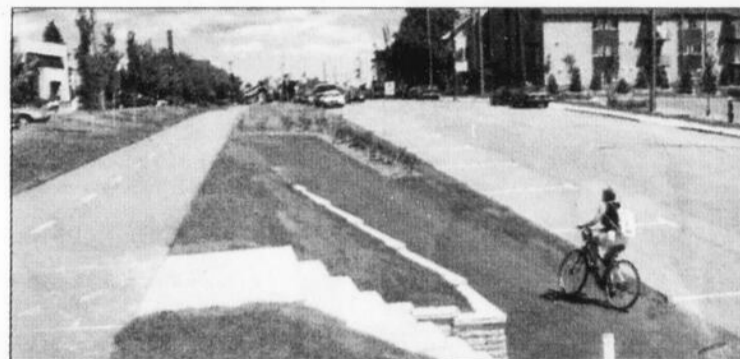
De nouveaux accès à la piste cyclable ont été aménagés pour la sécurité des piétons et des cyclistes. Un feu de circulation sera également installé dans les prochaines semaines.
