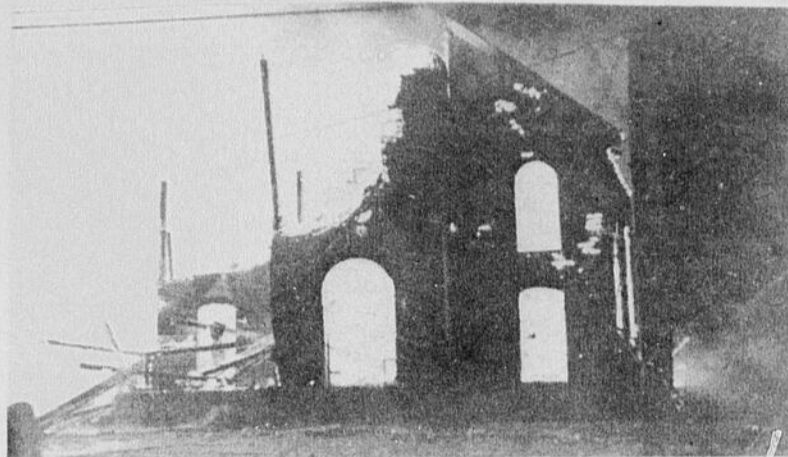
EGLISE EN FEU
