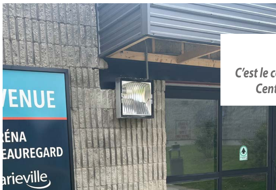
Les travaux de reconstruction des vestiaires de l'aréna de Marieville s'élèvent à 137 000 $, excluant les taxes.
