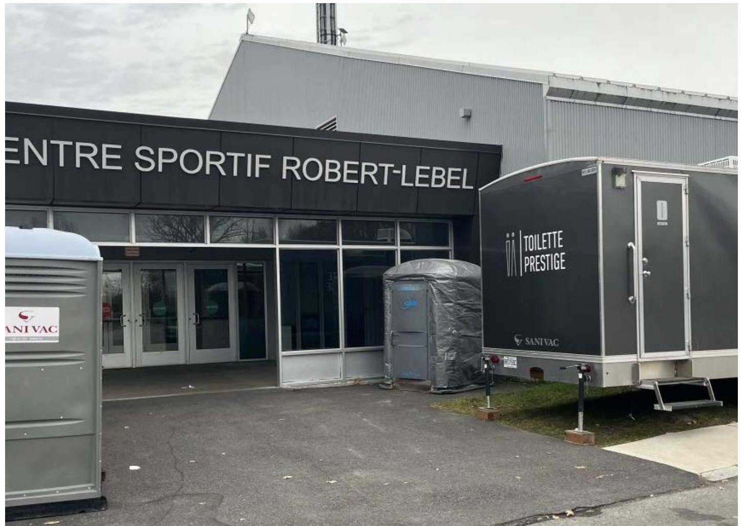
Il en coûte 4 125 $ par mois à la Ville pour la location, puis la manœuvre vidange-remplissage des toilettes de remplacement. (Photos : archives)
