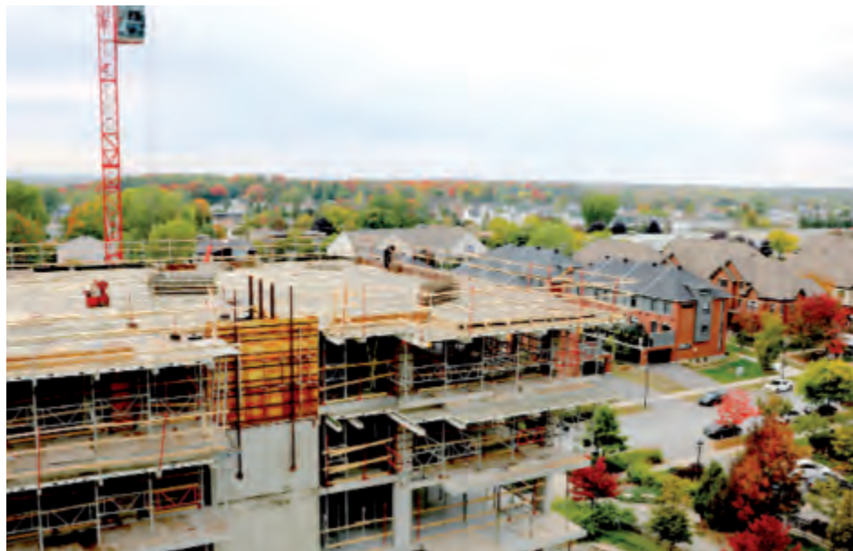
Les travaux de construction de la troisième phase progressent rondement.
