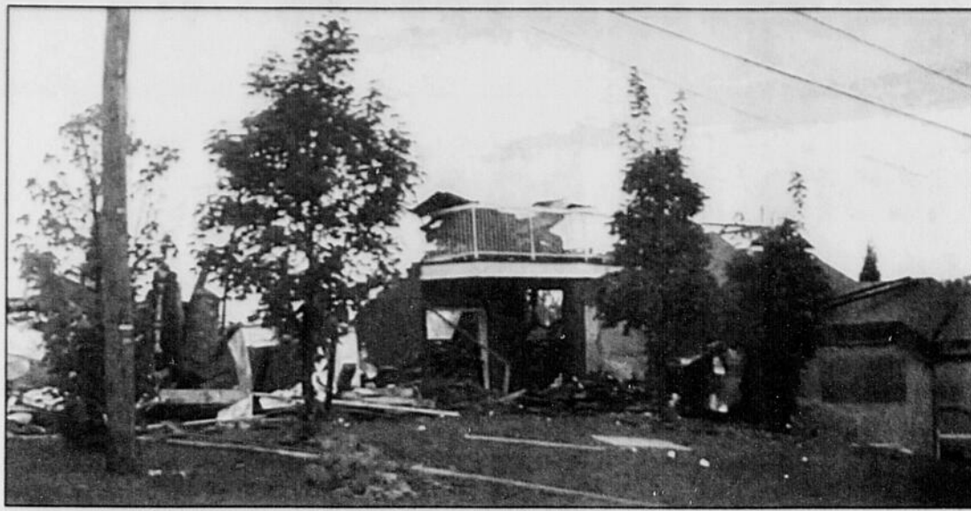
Les dommages causés par l'incendie qui a complètement rasé La Résidence Belval d'East Angus sont évalués à plus de deux millions de dollars. Heureusement, personne n'a été blessé, mais on a longtemps craint le pire.
