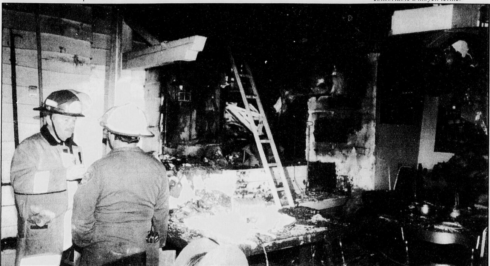
Téléphoto par Christian Landry A la Brasserie Daniel Lapointe, les flammes auraient pris naissance à la cuisine, au rez-de-chaussée, et se seraient rapidement propagées à la mezzanine et à l'entresol par les conduits de ventilation. Les clients ont été évacués sans incident.
