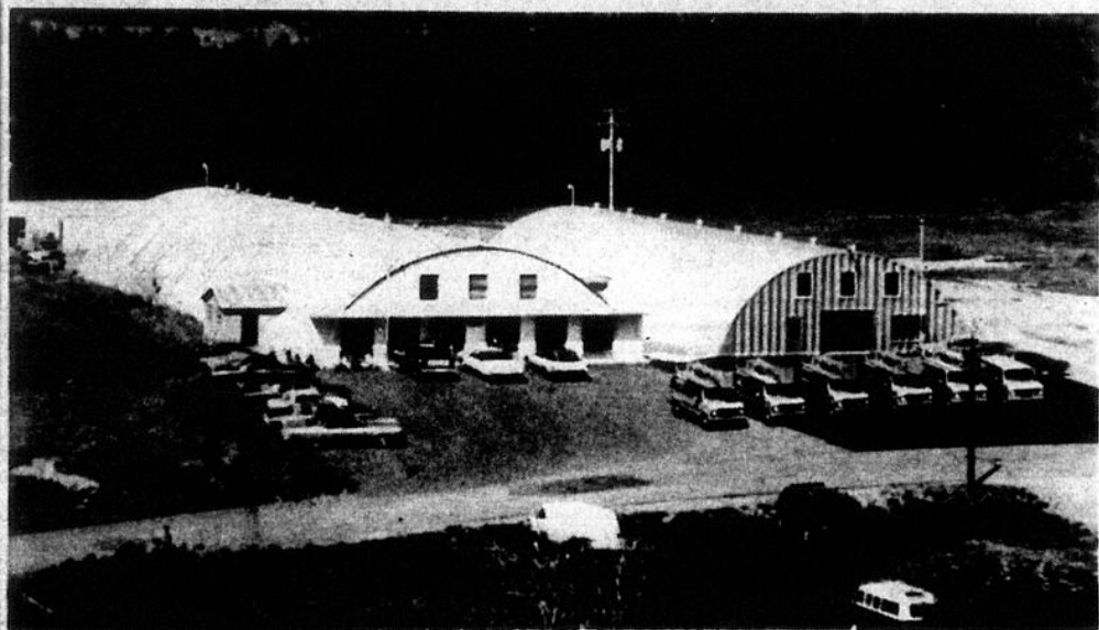
L'usine, vue de l'extérieur.
