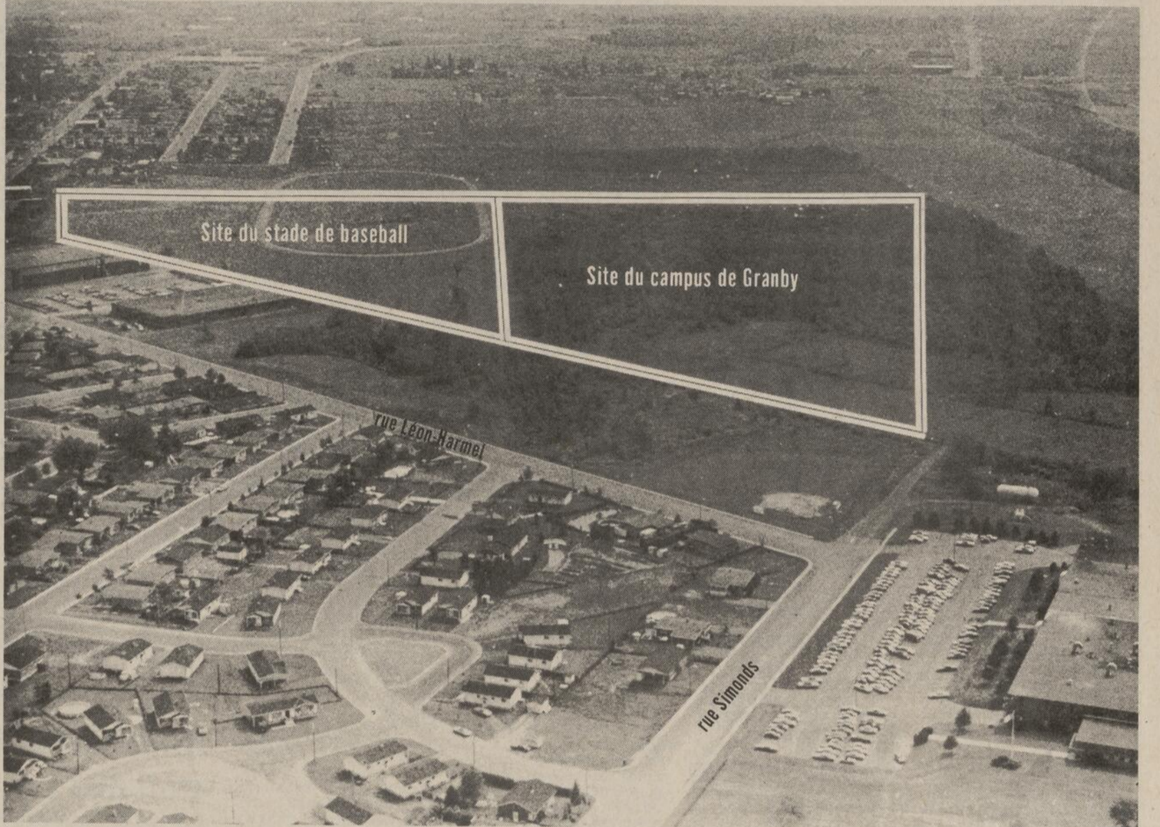
Le site du nouveau campus de Granby du Cégep de Sherbrooke occupera une superficie de quelque sept acres sur "Le Domaine du Verger Inc.", à Granby, dans le secteur ouest. Ce terrain est borné par la rue Simonds ou son prolongement et la rue Saint-Va-
