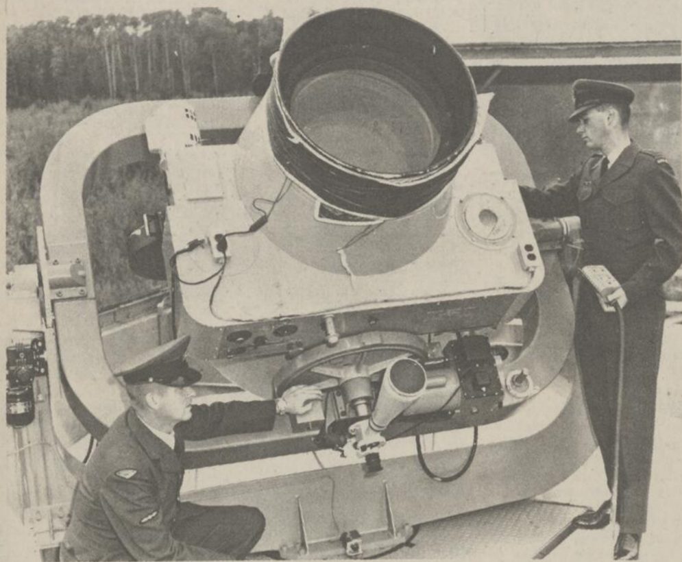
L'APPAREIL PHOTOGRAPHIQUE canadien Baker-Nunn situé à Cold Lake, en Alberta, placé sous le contrôle opérationnel du Commandement pour la défense aérienne de l'Amérique du Nord (NORAD), contribue également au système de défense spatiale. Les appareils Baker-Nunn utilisés par le Commandement de la défense aérienne des États-Unis à Edwards Air Force Base, en Californie, fonctionnent en vertu d'un contrat établi avec l'Institut de physique théorique de l'Université d'Oslo, Norvège. De concert avec le réseau mondial du Smithsonian Astrophysical Observatory, ils fournissent d'autres observations optiques sur la circulation dans l'espace. Ces appareils télescopiques, à contrôle électronique, peuvent photographier la lumière réfléchie par un objet de la taille d'un ballon à 50,000 milles dans l'espace. Ils peuvent obtenir la position précise d'un satellite en observant eux-mêmes la rotation de la terre et en photographiant contre un fond d'étoiles connues.
