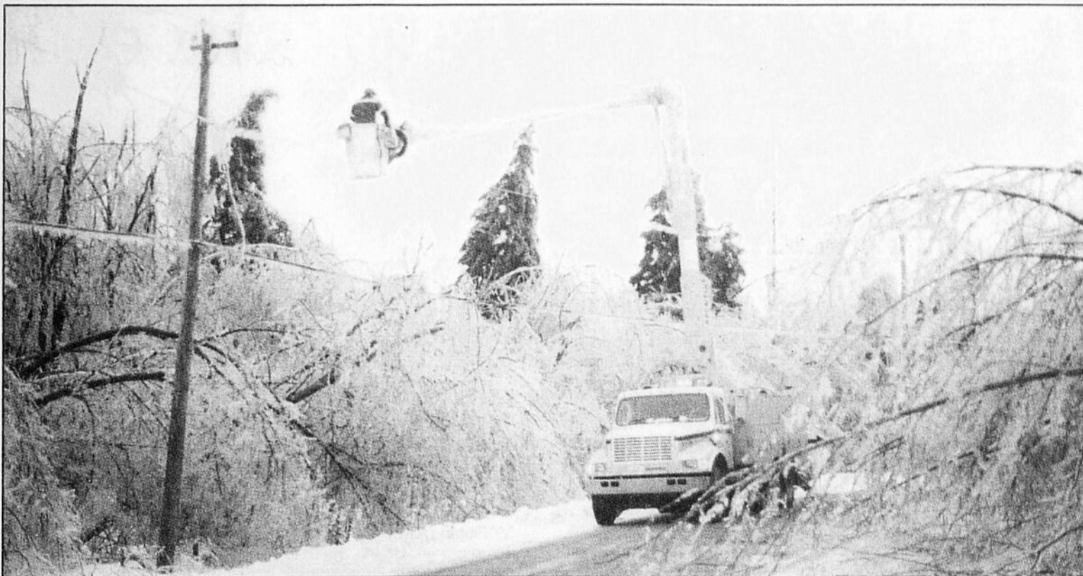
Il y a cinq ans, le Québec entrainait dans la crise du verglas, marquée par des pannes de courant prolongées. Environ 1000 pylônes, 16 000 poteaux de bois et 4000 transformateurs d'Hydro-Québec ont été endommagés.
