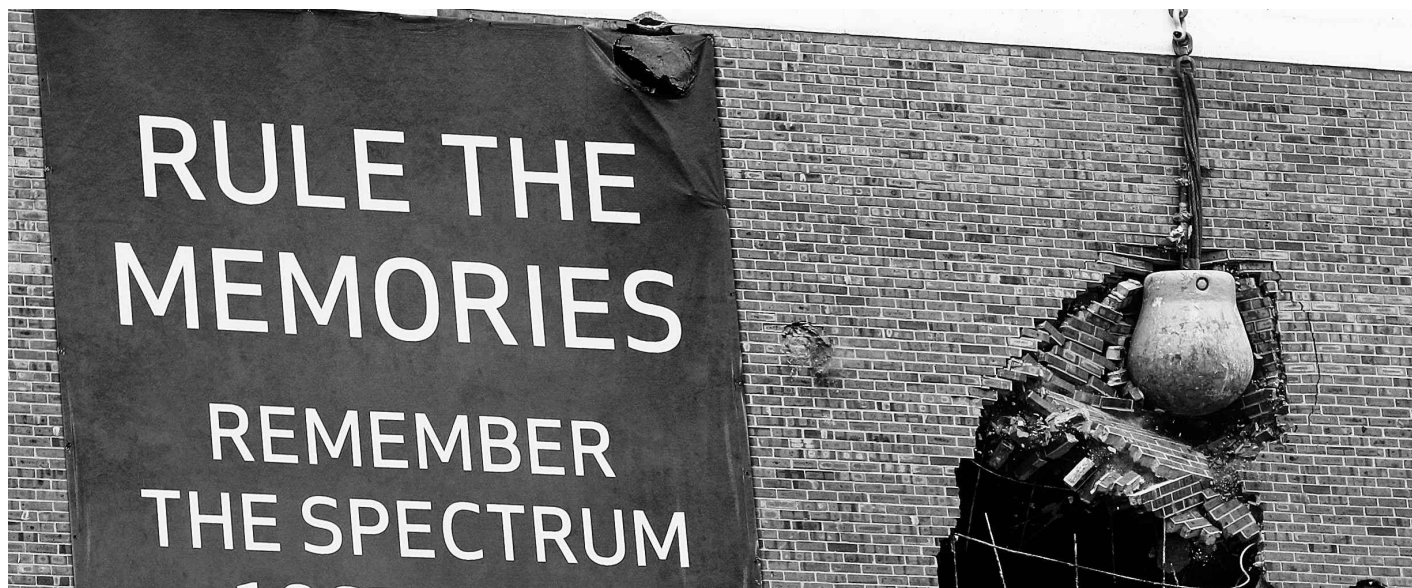
Au moment du passage de la voiture du maire Labeaume, la boule du démolisseur s'enfonçait dans le Spectrum. — PHOTO AP
