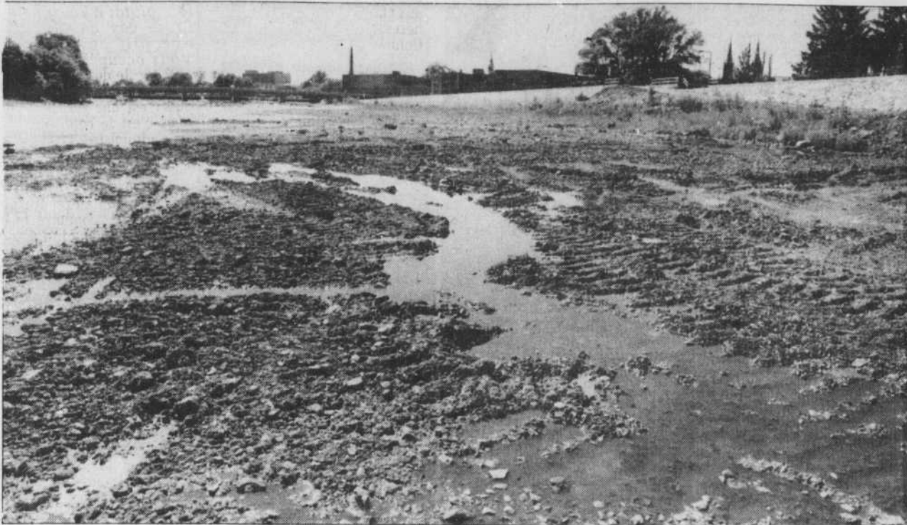
La Société d'assainissement des eaux avait l'accord du ministre de l'Environnement pour construire un intercepteur d'égouts au milieu d'une fraye, dans le lit de la Yamaska, à Saint-Hyacinthe. Par la suite, toutefois, cette photo montre qu'elle a aplani ses digues avec un béliier mécanique plutôt que de retirer tous ces matériaux étrangers et de recréer un habitat propice aux poissons.
