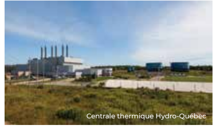
Centrale thermique Hydro-Québec
