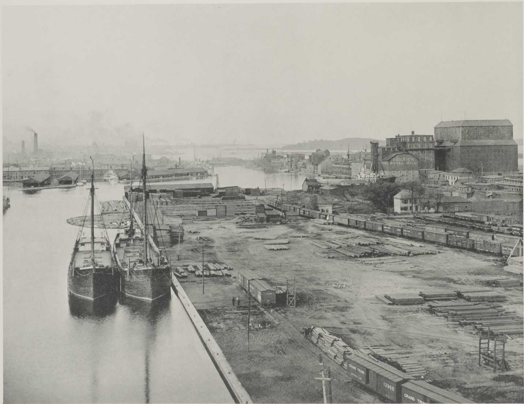
LACHINE CANAL FROM G. T. R. OFFICES.
