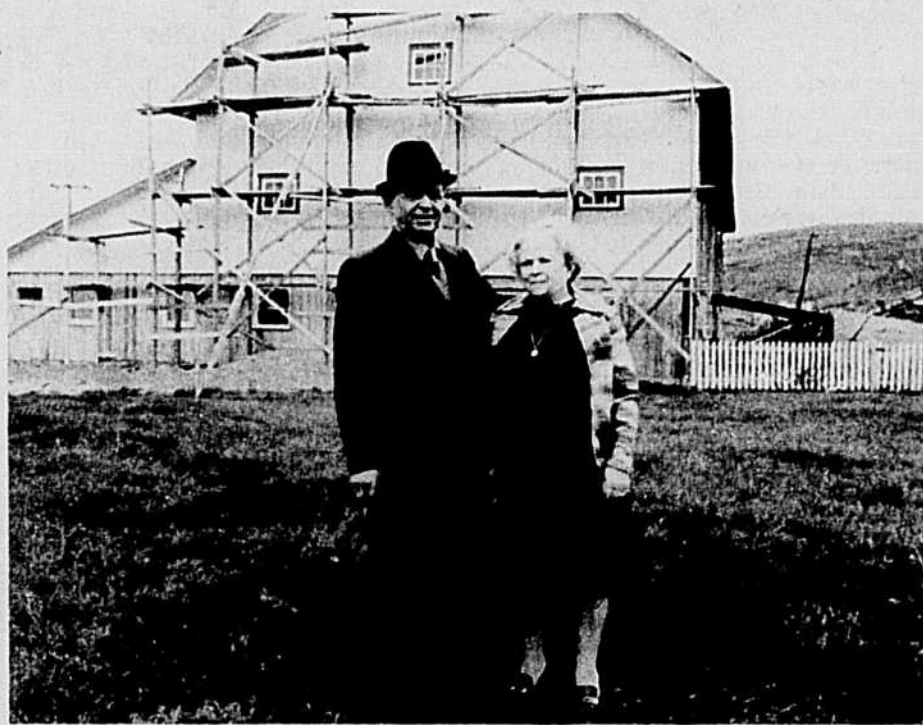
M. Omer Filion et son épouse devant la grange qu'il a lui-même construite en 1922 et qu'il est présentement à rénover.
