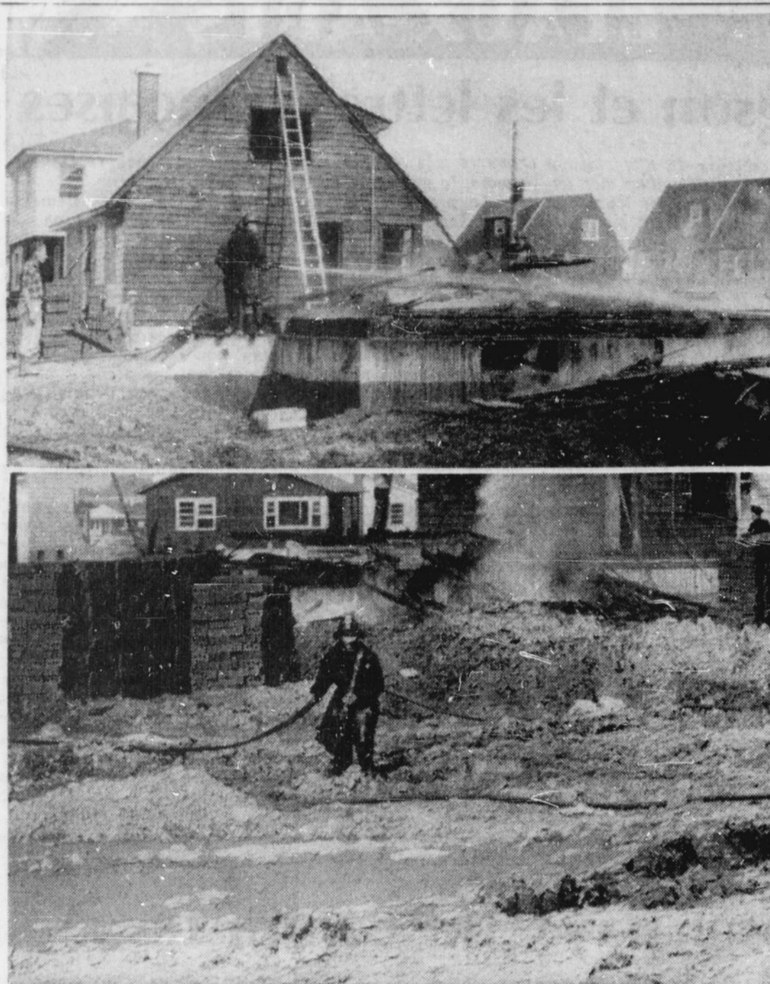
PRES DE $30,000 DE DOMMAGES — Un violent incendie a réduit en cendres, ce matin, une maison en voie de construction au cœur d'Elmvalley Acres, vaste projet d'habitations de la compagnie Capeau dans le voisinage du boulevard Saint-Laurent, près du chemin Smyth. Deux autres maisons partiellement construites ont été considérablement endommagées. La photo du haut montre les ruines de la maison, rue Naples. Au bas, on remarque un sapeur, les pieds pris dans la boue, en train d'arroser les débris fumants. (Photos "Le Droit" — par Champlain Marcell)
