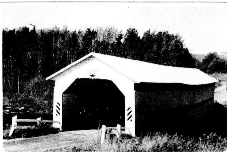
LA FIN D'UNE EPOQUE. C'est avec nostalgie que les adeptes de plein air qui se rendront au Centre Ixworth, de St-Onésime, regarderont désormais ce vieux pont couvert datant de 1909. En effet, le 14 septembre dernier, on procédait à la bénédiction du nouveau pont de béton qui le remplacera. Voir autre texte en page 13 du cahier B.
