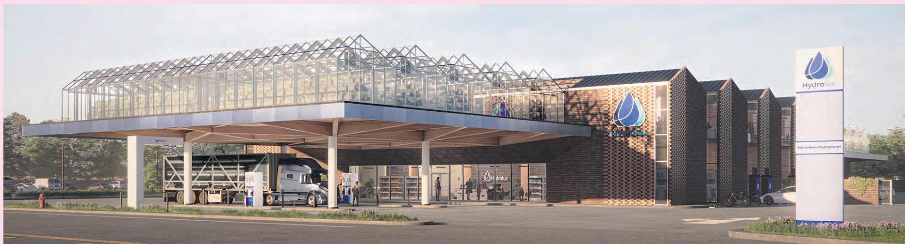
Le coût de construction de la station de ravitaillement en hydrogène vert à Val-d'Or devrait tourner autour de 50 millions de dollars.
