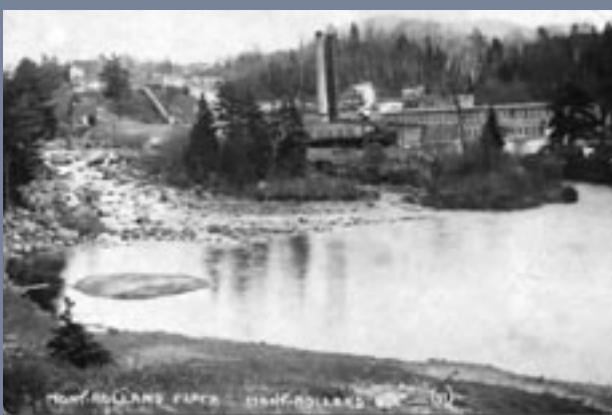
Usine Rolland de Mont-Rolland
