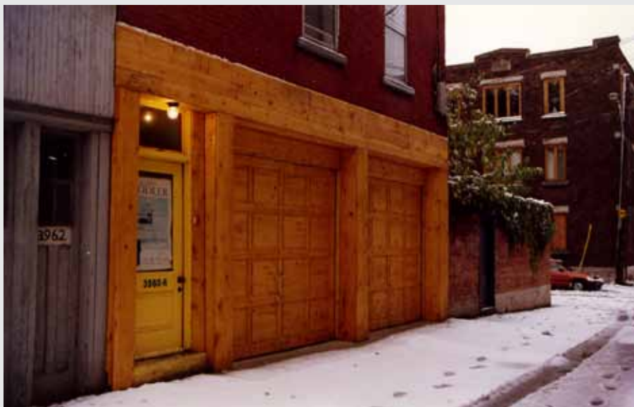
Nouvelles portes pour les deux garages.
