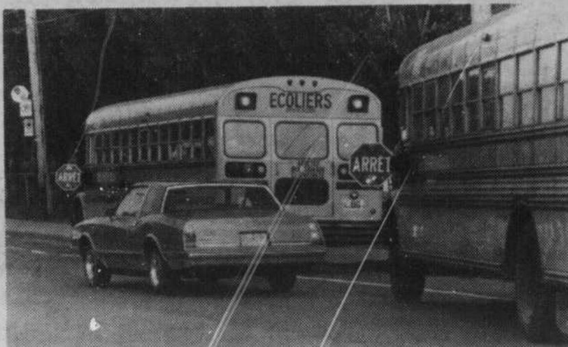
Lorsque la portière de l'autobus s'ouvre, automatiquement le bras d'arrêt s'allonge sur le côté du véhicule. Il est strictement défendu de le dépasser. (Photo Lucie Bernard)
