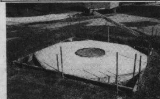
Une dalle de nivellement fraîchement coulée.
