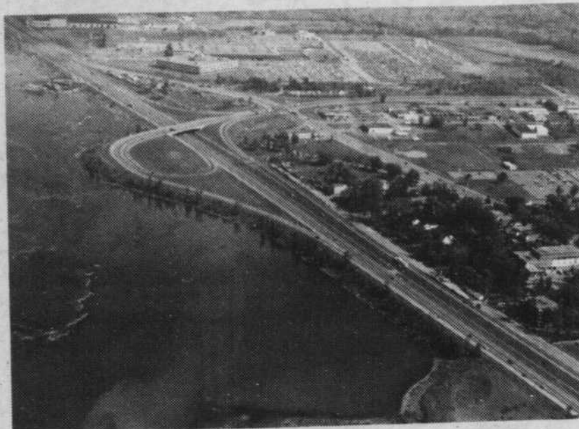
D'importants travaux sont déjà en cours dans le lit du fleuve, juste devant la compagnie Pratt & Whitney. (Photo: Danny McKenzie).
