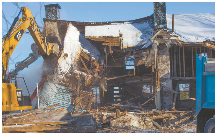
La démolition de la maison Boileau à Chambly, le 22 novembre
