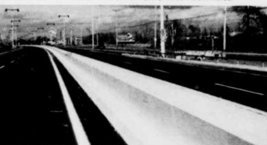
Muret médian de la voie rapide Côte-de-Liesse à Montréal.
