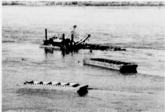
Photo 1 — Dragage au Cap-à-la-Roche.
