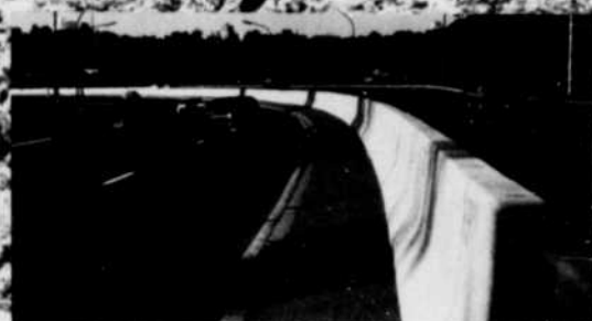
La route Don Valley Parkway, à Toronto, est divisée par un muret de sûreté.
