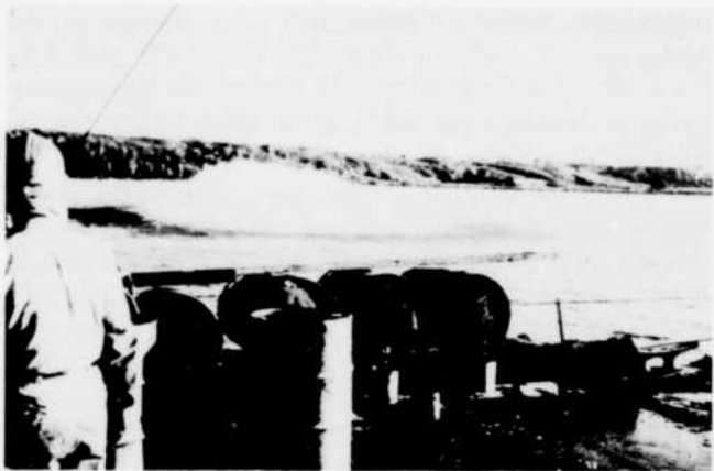
Photo 2 — Dynamitage au Cap-à-la-Roche.
