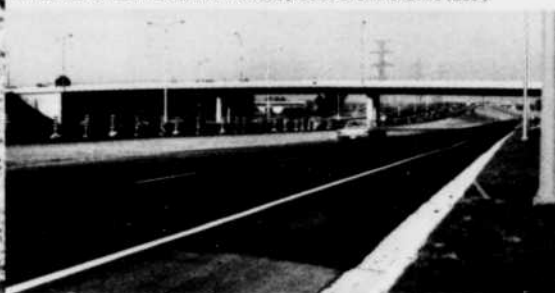
Viaduc franchissant la route Queen Elizabeth Way à Toronto.
