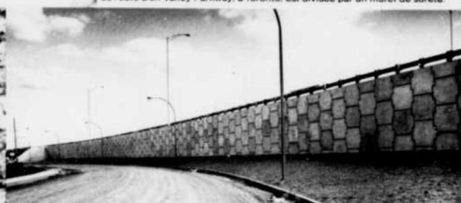
Mur de soutènement constitué d'éléments de béton préfabriqué, près de Trois-Rivières.
