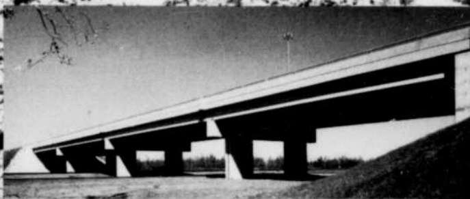
Viaduc tout en béton à Grantham-Ouest, près de Drummondville (Qué.).
