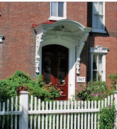
La marquise protège tant les résidents que la porte et son encadrement de la pluie.
