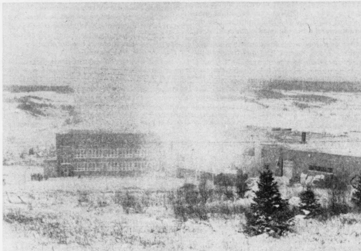
C'est la toiture de l'immeuble de quatre étages qui a le plus souffert et une équipe était au travail, hier, pour calmer la brèche.
