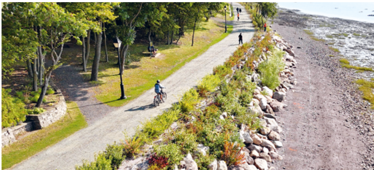
Vue des berges stabilisées de la Plage-Jacques-Cartier, un an après les travaux d'enrochement végétalisé.
