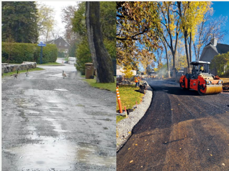
La rue Leclair, à Laval, avant et après les travaux de recouvrement d'asphalte poreux pour en faire une rue éponge.
