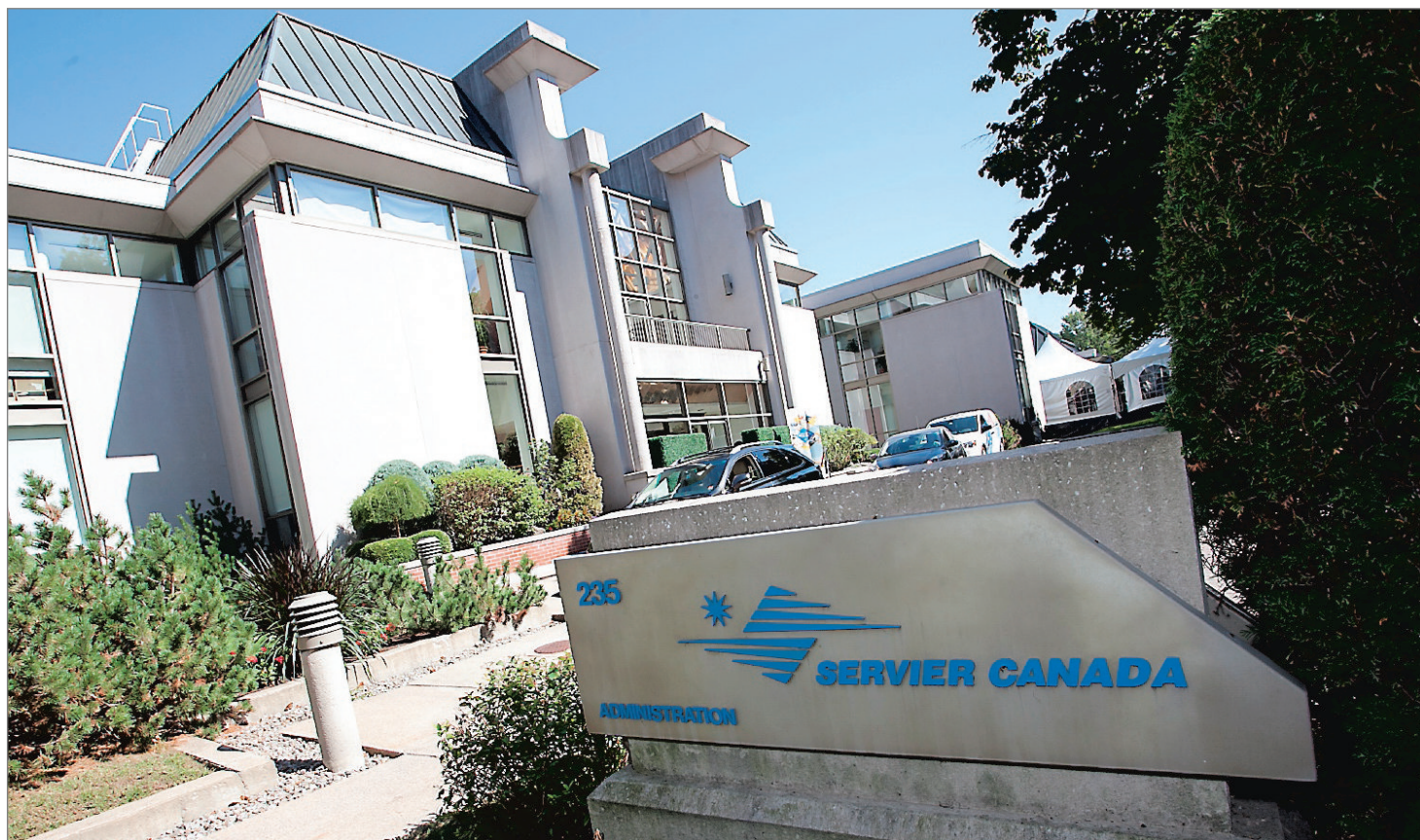
Le 6 septembre 2013, la compagnie pharmaceutique française Servier a annoncé la construction d'un centre d'excellence en recherche clinique à Laval, au coût de 16.3 M$. PHOTO ALARIE PHOTOS
