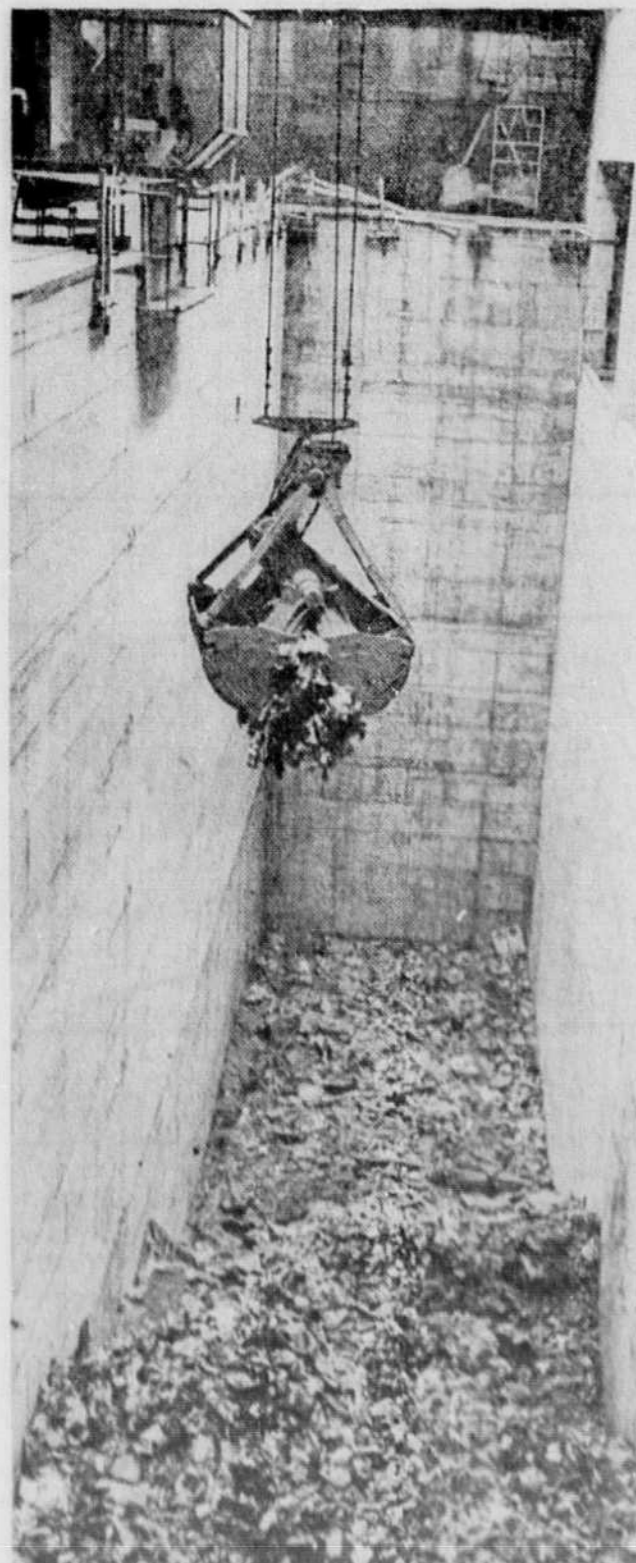
Les camions apportent les milliers de tonnes de déchets au plancher de déchargements qui est vidé dans la fosse à rebuts puis de là des grues transportent ces restants dans quatre vibreurs d'alimentation pour déchiqueter le tout. Ce qui reste de l'opération tombe dans les fourneaux où tout est brûlé.
