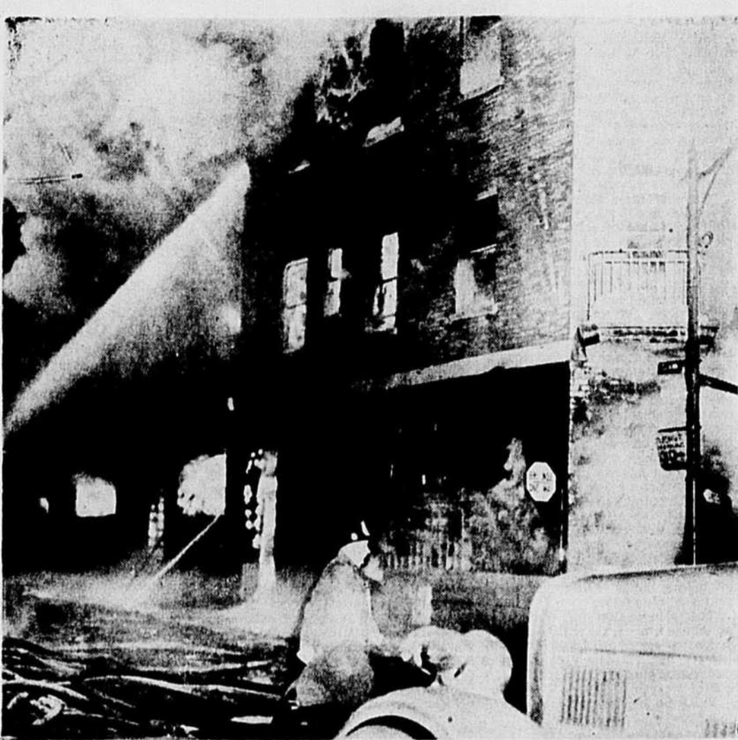
Il était 6 heures à peine hier matin lorsque le photographe du "Canada" arriva sur la scène du terrible incendie qui a ravagé le quartier chinois et a coûté, à date, la vie à 4 personnes. Les pompiers avaient déjà installé des milliers de pieds de boyaux et le feu faisait déjà rage partout à l'arrière du Lotus Garden. Des dizaines de personnes ont sauté des six fenêtres que l'on voit à l'avant-plan de la photo. Une des victimes de la tragédie, Ling Shew, âgé de 55 ans, s'est fracturé le crâne sur le pavé en sautant de la fenêtre du troisième étage, à gauche. (Photo "Le Canada", par Sasville)
