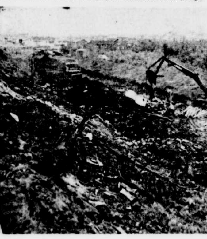
LA DEMANDE DES LOTS continue à se faire nombreuse dans le secteur St-Jean-Baptiste de La Salle. C'est pourquoi on aperçoit ci-dessus une petite mécanique ouvrir une tranchée pour la construction de l'égout dans le prolongement de la rue des Bouleaux. A l'arrière, une vue générale du secteur.
