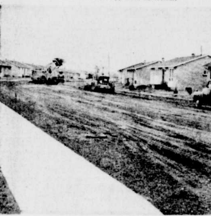
SUR LA RUE DES BOULEAUX, une des rares artères du secteur St-Jean-Baptiste de La Salle où on peut trouver un trottoir, on a préparé l'infrastructure du pavage.
