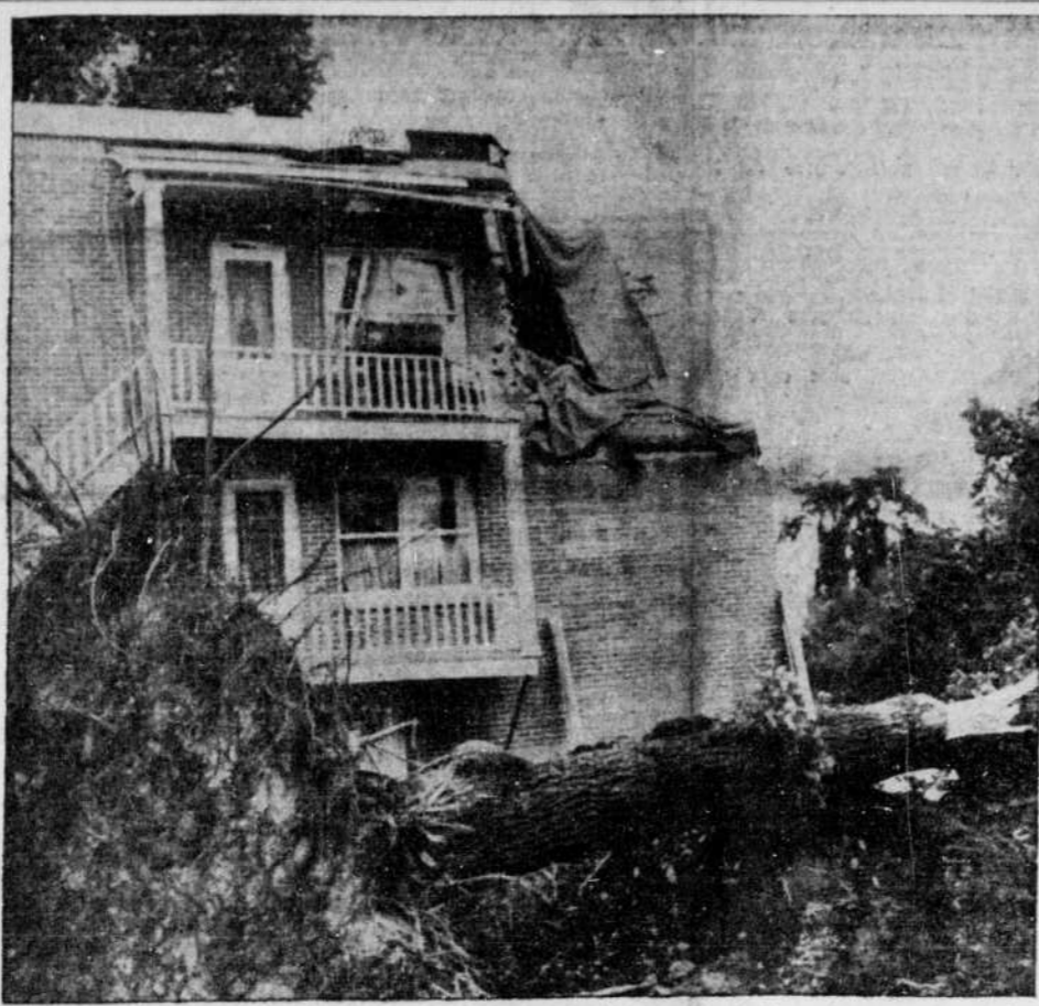
Un arbre est mal tombé, rue Belvédère! — Un accident peu banal est survenu, rue Belvédère, alors que M. Ephrem Jacques essayait de faire tomber un gros arbre en le tirant avec un "bull-dozor". L'arbre, en effet, est bien tombé mais au mauvais endroit comme on peut en juger par cette photographie. Dans sa chute, le gros orme
