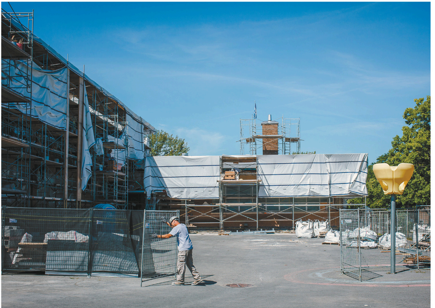
À l'école Saint-Jean-Vianney, comme dans bien d'autres établissements scolaires, les ouvriers sont toujours à l'œuvre alors que la rentrée des écoliers s'amorce. VALÉRIAN MAZATAUD LE DEVOIR
