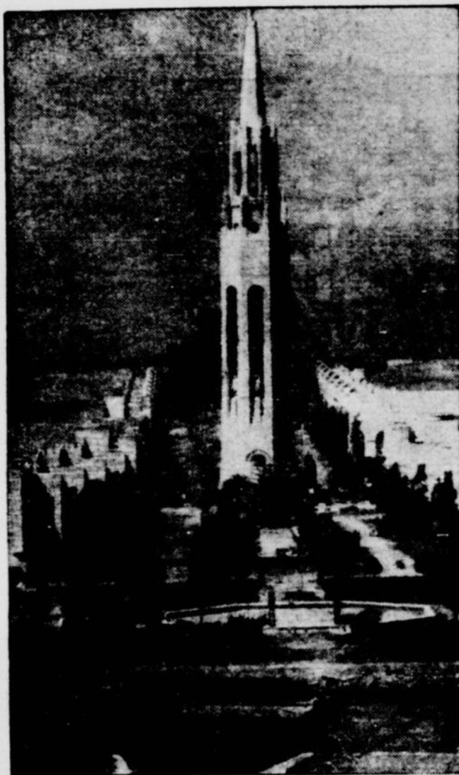
Les édifices du corps principal de la Porte d'Or sont pratiquement terminés à San Francisco.
