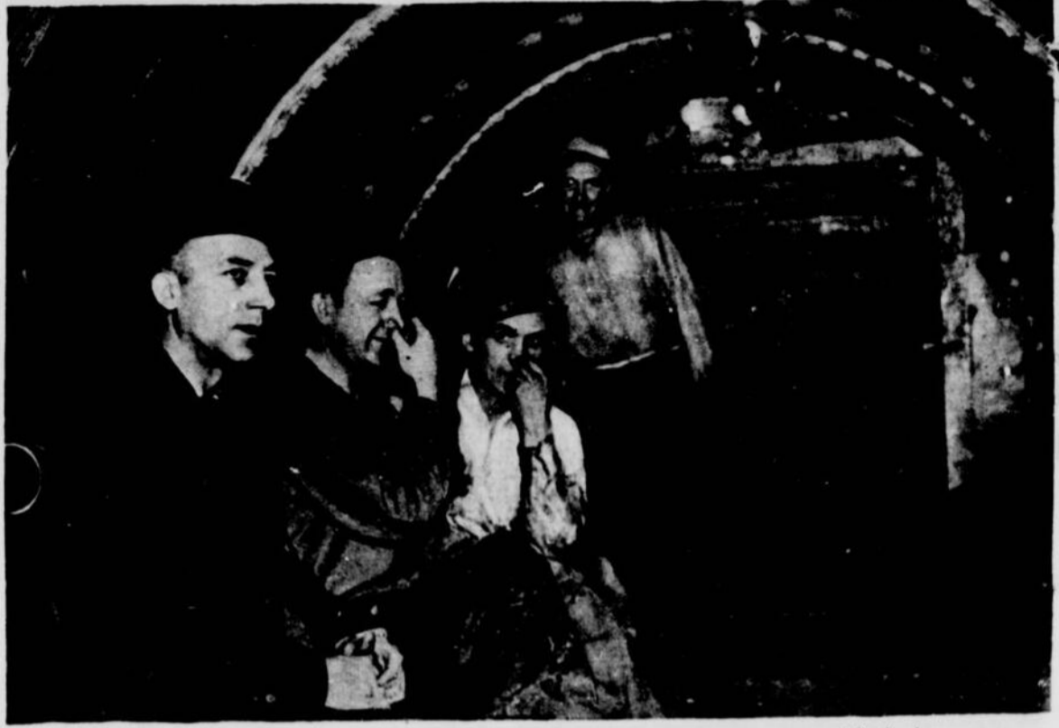
Voici les employés au creusage dans la chambre de compression. Là, ils chassent l'air de l'extérieur en pinçant le nez et en soufflant pour qu'elle leur sorte par les oreilles. Ils doivent ainsi s'habituer à respirer dans une atmosphère où la pression est de 25 livres.
