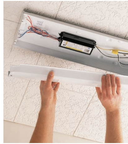
A. Enlevez le diffuseur, le tube et la plaque.
