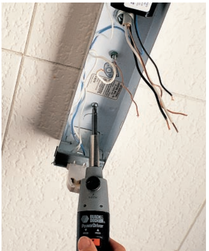
H. Dévissez le luminaire du plafond ou du mur; enlevez-le avec soin. Soutenez le luminaire lorsqu'il se détache.
