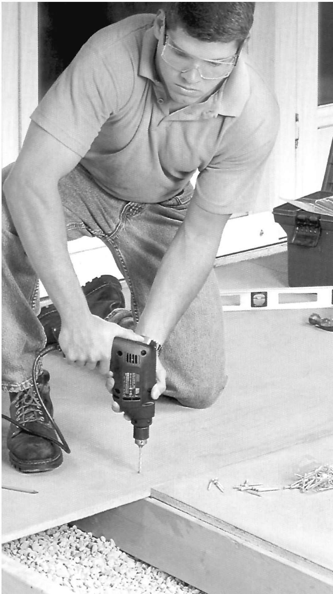
Le panneau de béton modifié pour les balcons s'installe comme le contreplaqué.
