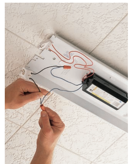
E. Installez la nouvelle douille avec des serre-fils.
