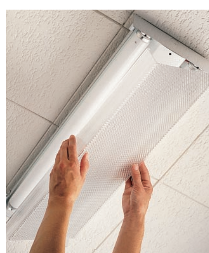
K. Installez la plaque du nouveau luminaire, le ou les tubes ainsi que le diffuseur. Rétablissez le courant au tableau de distribution principal.
