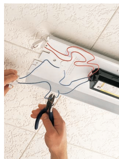
D. Détachez les fils reliés à la douille.
