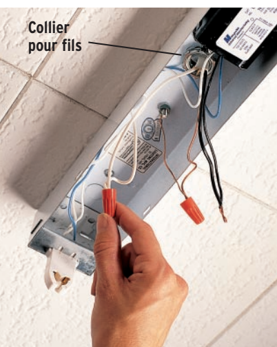
G. Détachez du luminaire les fils de circuit isolés et le fil de mise à la terre nu. Desserrez le collier qui retient les fils de circuit.
