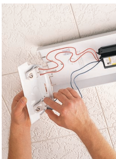
C. Enlevez la douille défectueuse de son logement.
