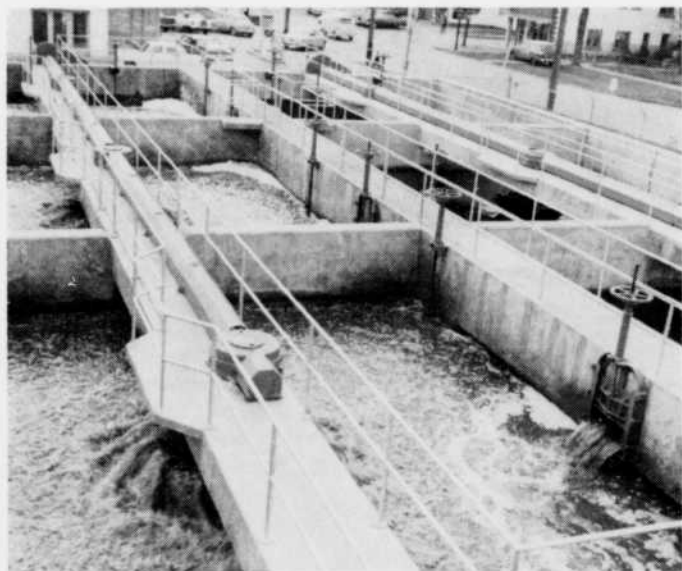
Vue des bassins d'aération mécanique, West Side Plant, Port Colborne, Ontario. Projet : Canadian British Engineering Consultants.
