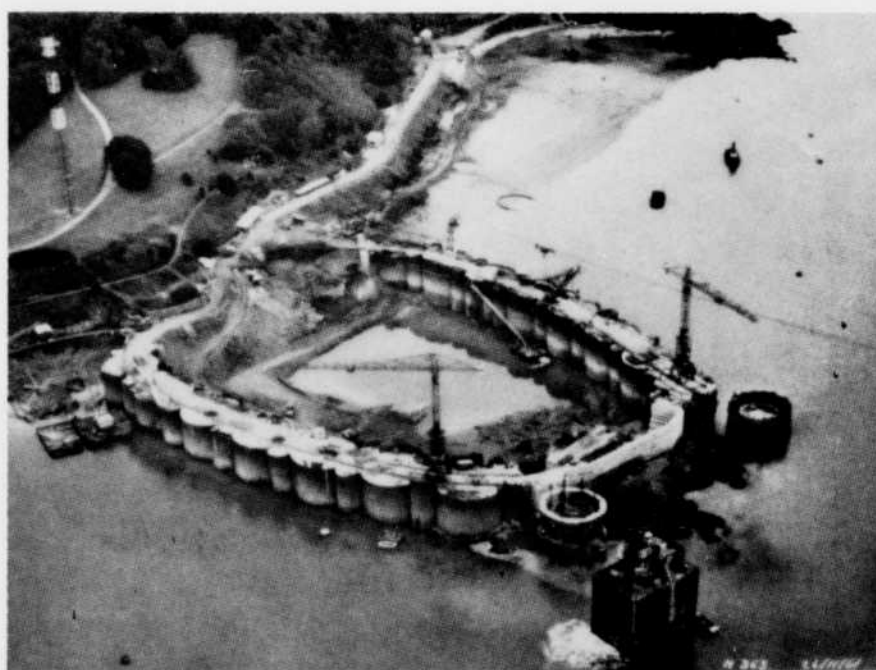
Fig. 7 — État des travaux sur la rive droite, fin novembre 1961.
