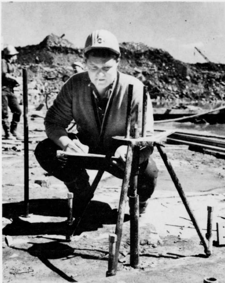
Appareil lecteur de mesures de déformation du rocher traité.
