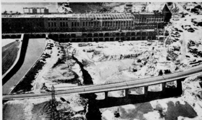
BEAUHARNOIS. Stratégiquement située à la sortie du canal de 15 milles reliant les lacs Saint-François et Saint-Louis, cette centrale comprend 36 groupes principaux. L'excavation de ce canal a exigé l'enlèvement de 15% de déblais de plus que le canal de Panama et deux fois plus que la Voie Maritime du Saint-Laurent.
