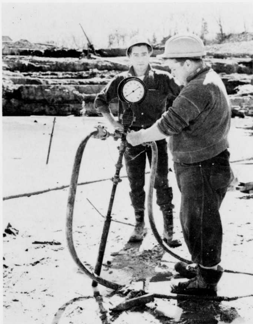
Tête d'assemblage du dispositif d'injection.
