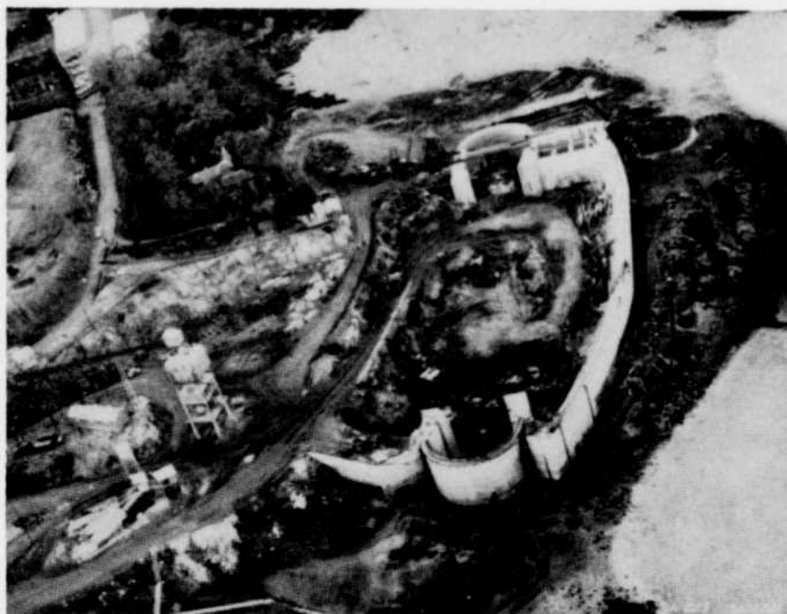
Fig. 8 — État des travaux sur la rive gauche, fin novembre 1961.
