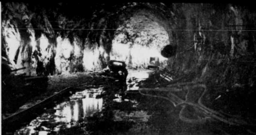
STATION GÉNÉRATRICE I DE BERSIMIS. Pour cette station de 7.5 milles de long, on a creusé dans le roc un tunnel de 31.5 pieds de diamètre à l'aide des explosifs C-I-L. Huit groupes électrogènes de 150,000 h.p. occupent chacun une centrale enceinte de montagnes. De Bersimis, des câbles de 300,000 volts rejoignent Québec, Montréal et les câbles atteignant la péninsule de Gaspé sous le Saint-Laurent.
