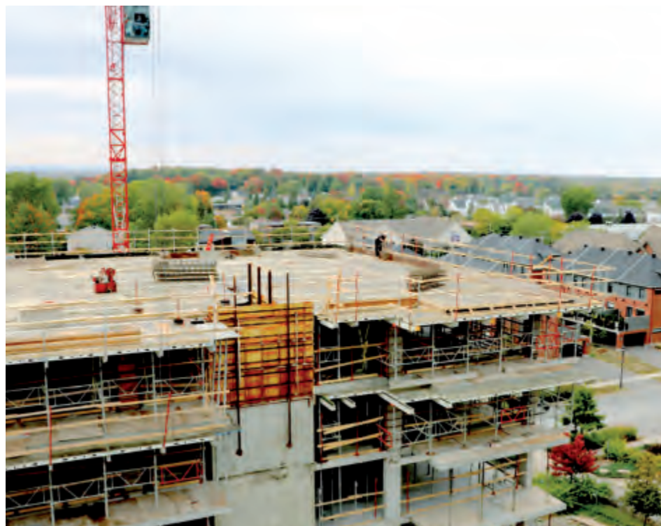
Les travaux de construction de la troisième phase progressent rondement.
