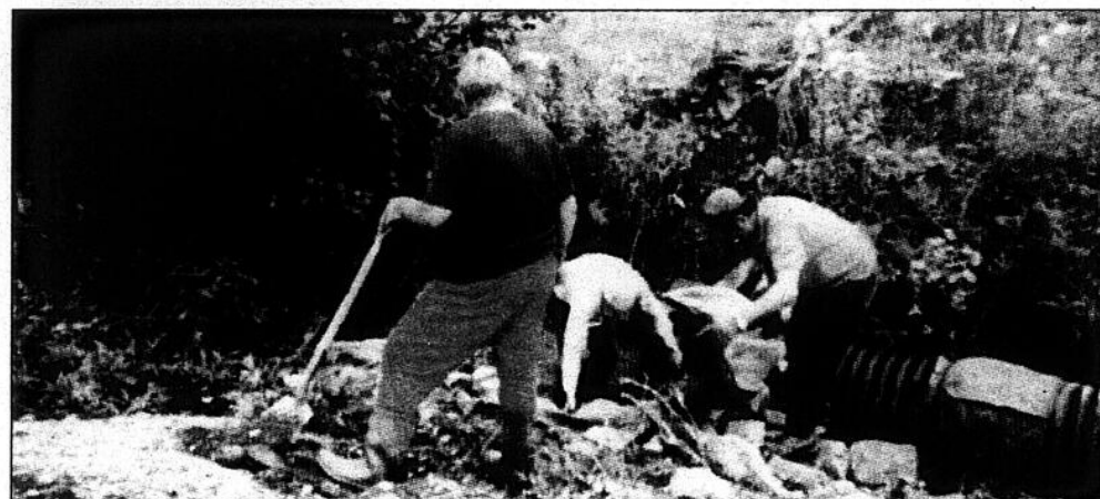
Les traverses pour la machinerie et pour le troupeau (celle en bois) qui ont été construites au-dessus du ruisseau.
