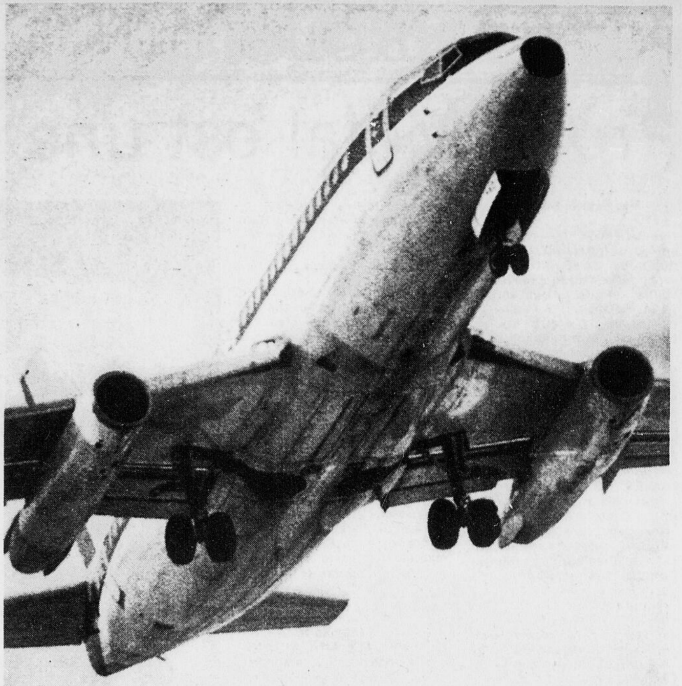
ATTERRISSAGE RISQUE — Les dommages au pneu extérieur gauche sont parfaitement visibles alors que ce 737 de Transair survolait à basse altitude l'aéroport de Winnipeg afin de se faire indiquer par des observateurs
