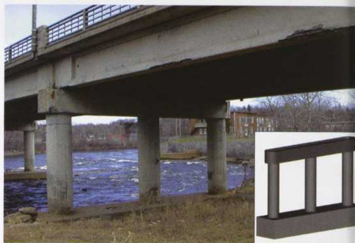
Pont de la route 138 sur la rivière Sainte-Anne et modèle 3D à l'échelle 1/3 d'un appui du pont qui sera soumis à des essais pseudo-dynamiques.
