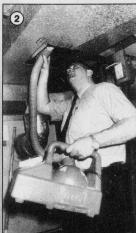
2 Avec ce pulvérisateur, on décontamine efficacement l'intérieur de vos conduits de ventilation.
