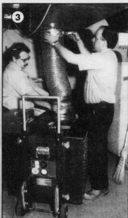
3 Avec ce capteur de poussière, on aspire littéralement toutes les saletés à l'intérieur de vos conduits.
