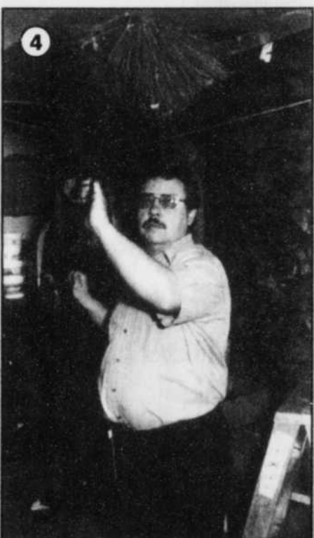
4 C'est avec cette brosse qu'on enlève la poussière qui sera aspirée par le capteur. Avec ce traitement, vos conduits de ventilation seront propres pour 10 ans.
