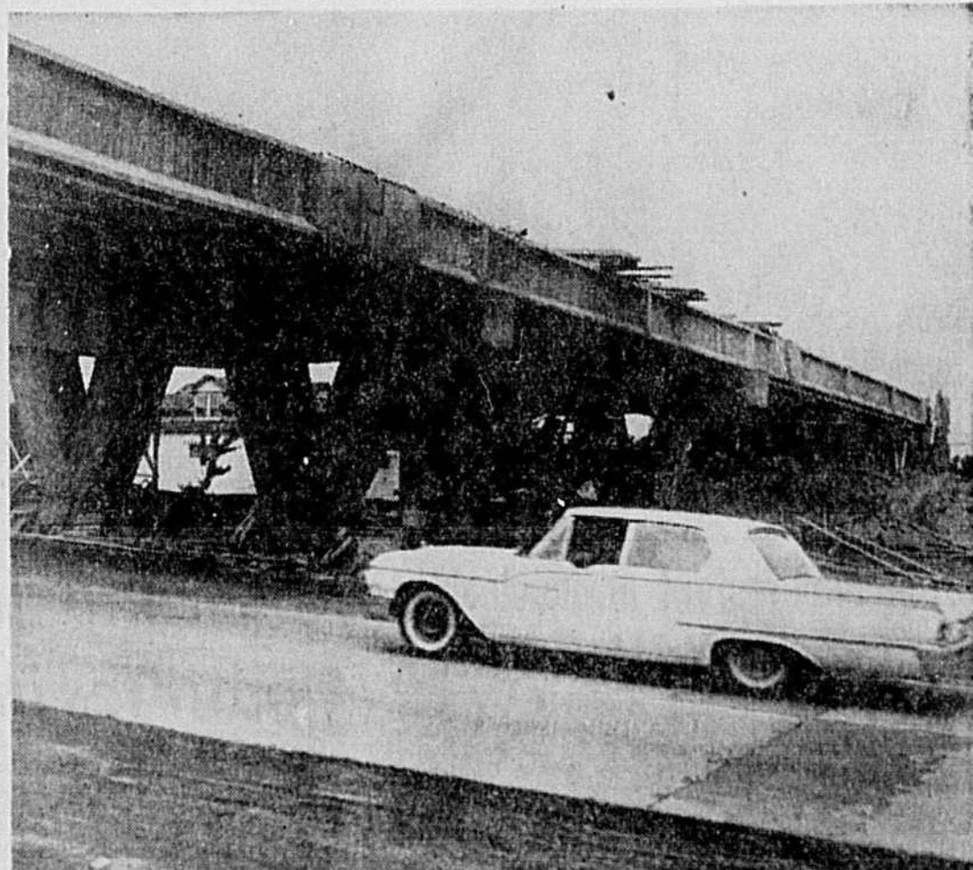
• L'infrastructure du viaduc de Québec est terminée. L'on procédera sous-peu au revêtement de béton de cet ouvrage de 240 pieds de long. (Photo-Voirie)
