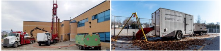
Installation pour le forage (gauche) et essais de réponse thermique et de pompage sur un PCP (droite).
